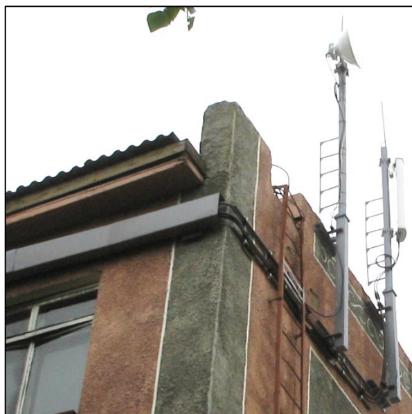
Рис. 120. Прокладка кабелей по фасаду
