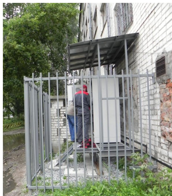
Рис. 118. Аппаратная, размещенная на земельном участке
