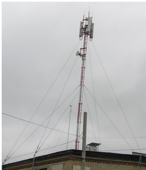
Рис. 6. Размещение антенн на мачте
