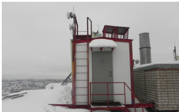
Рис. 52. Аппаратная, размещенная в отдельном контейнере
