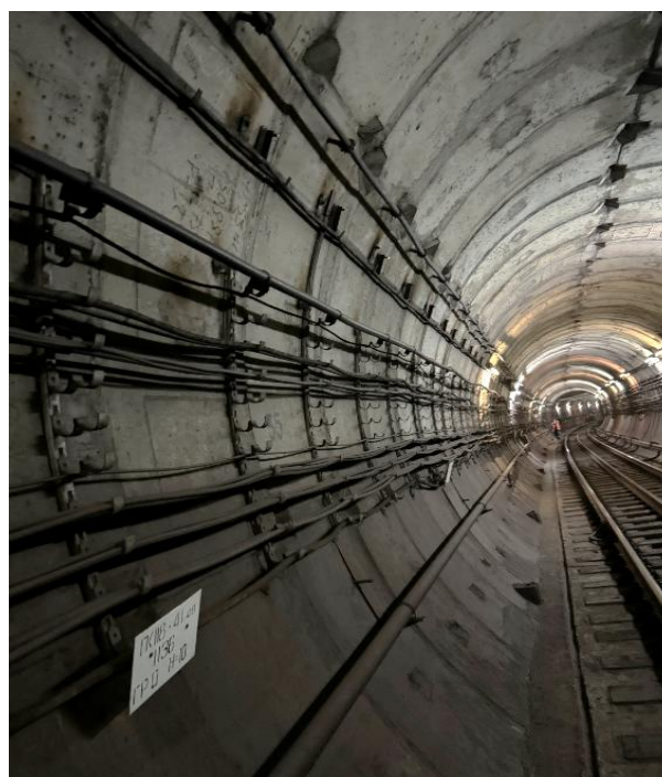
Рис. 131. Скрытая прокладка кабеля
