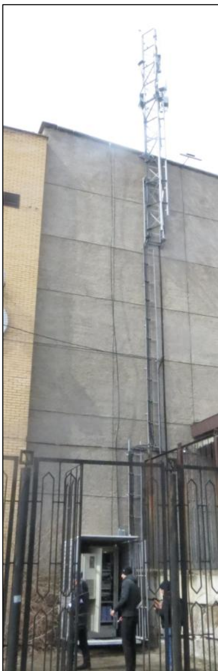
Рис.19. Прокладка кабелей по фасаду
