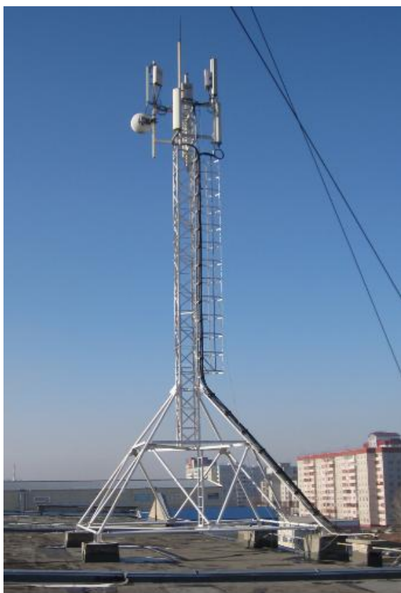
Рис. 7. Антенны, смонтированные на башне
