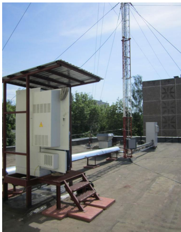
Рис. 3. Аппаратная, размещенная в телекоммуникационном шкафу
